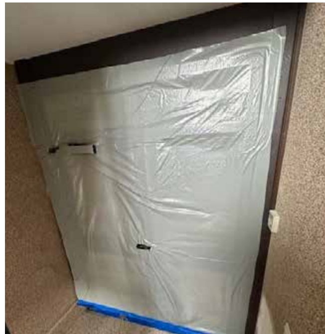
Die Schadstoffsanierung hat begonnen. Dafür wurden im ganzen Haus Schleusen eingerichtet.
